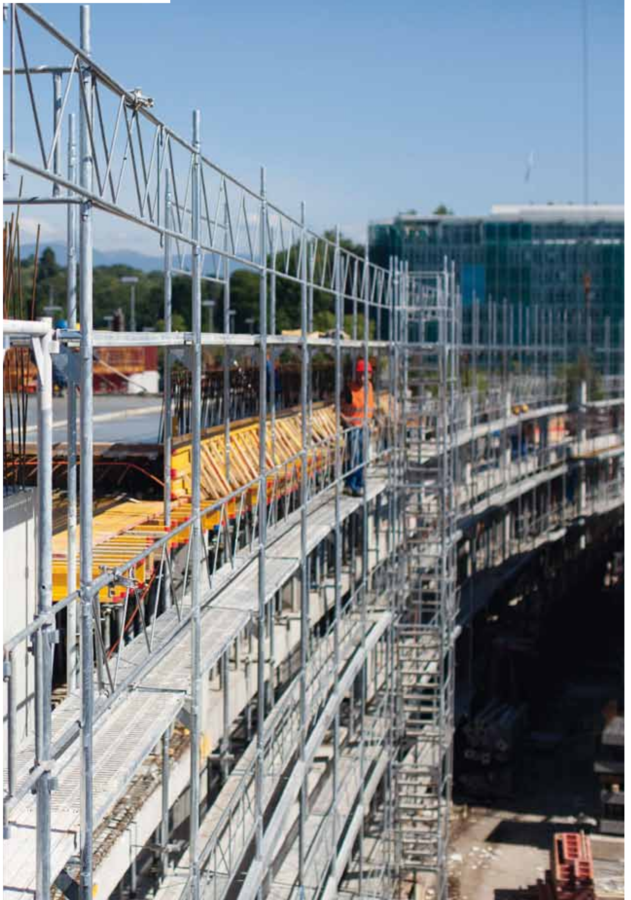
Le chantier de la Maison des étudiants
